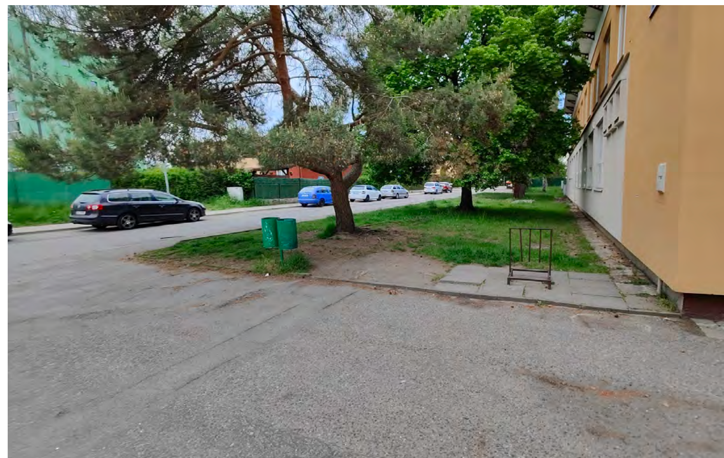
Vstupní prostor před samotnou budovou ZŠ, pozůstatky zastaralého mobiliáře a nevyhovující zpevněné povrchy.
